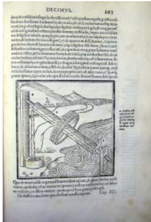
ウィトルウィウスの「建築書」 に記述されている「アルキメ デスの水汲みポンプ」の図 (⇒ 22)
